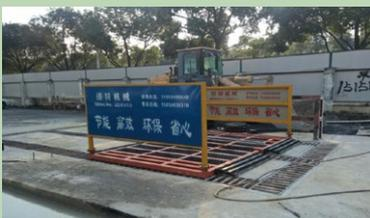
苏州礼安项目对原洗车台进行改造，安装成品自动洗车台，冲洗后的污水经过三级沉淀过滤后，循环使用，节约用水。
