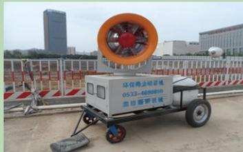
济南万象城项目土方作业采用湿法作业，用可移动式防尘雾炮对现场土方区域进行降尘。
