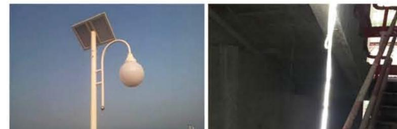
深圳前海项目施工现场主干道使用太阳能节能
